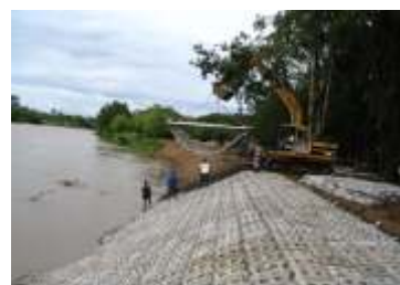
Estabilización de taludes en ríos
