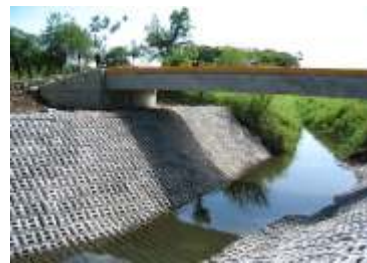
Protección de puentes
