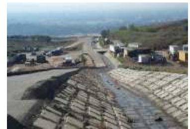
Canales de descarga en rellenos sanitarios
